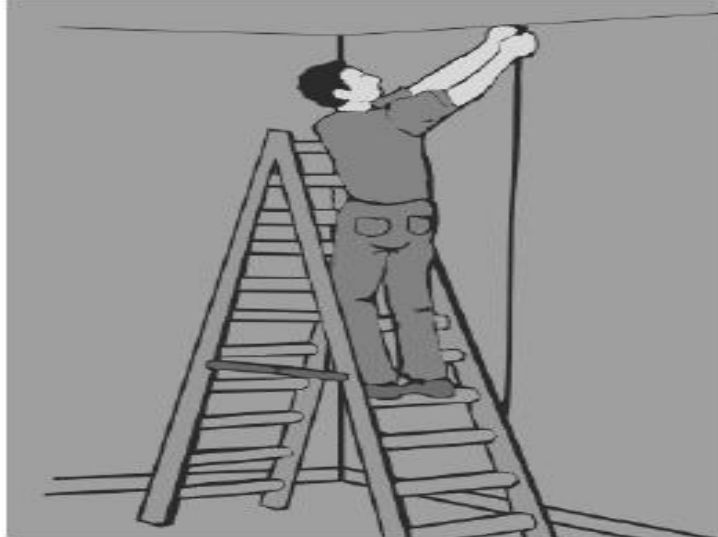
Figura 132 – Marcação do caminho do eletroduto na parede.
