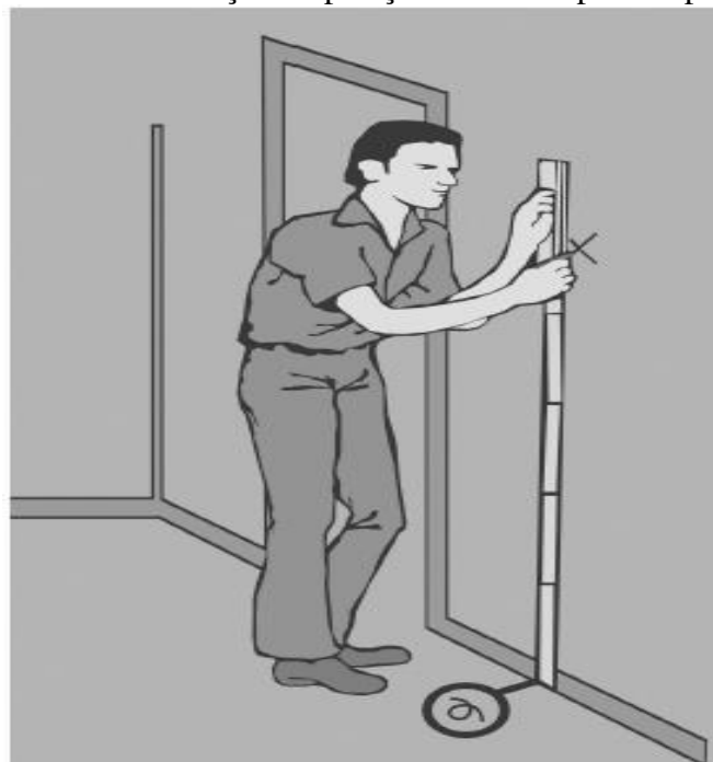
Figura 131 – Marcação da posição do interruptor na parede.
