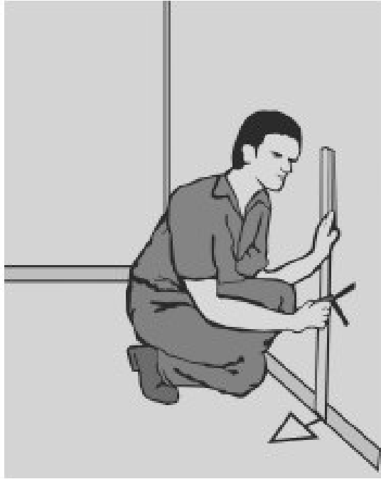
Figura 127 – Marcação do ponto de tomada na parede.
